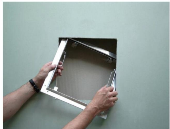
2. Türblatt aushängen, Rahmen diagonal durch den Ausschnitt führen und auflegen
