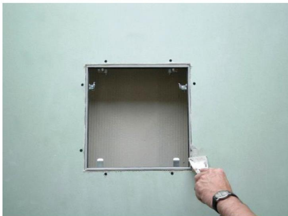
5. Decke und Klappe einzeln verspachteln
