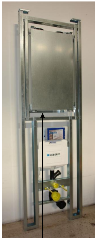
Ausschubmodul mit KL170 mit montiertem Montagedeckel verhindert Beschädigungen während der Bauphase
