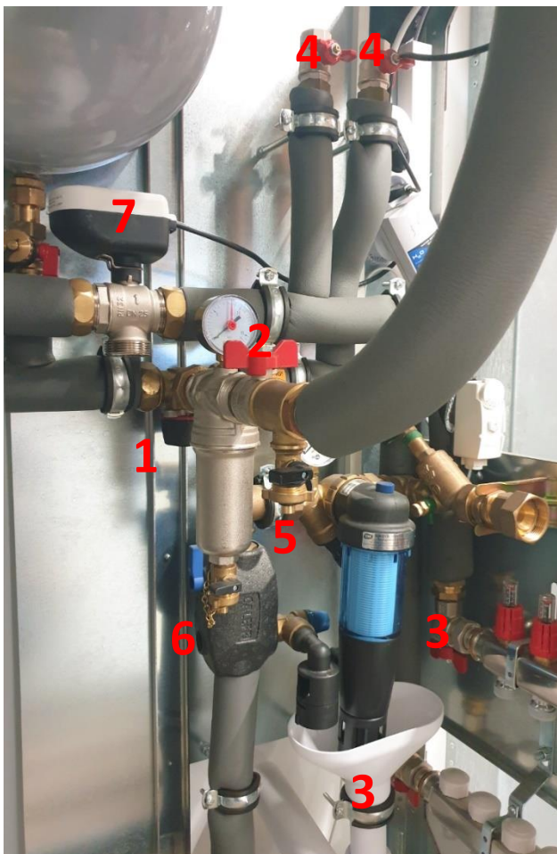
1 Stellung 3 beim Spülen der Fußbodenheizung für EG und OG
